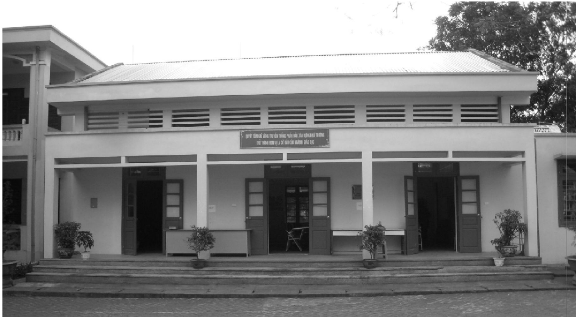
Nhà đa năng do SEQAP đầu tư xây dựng tại Trường Tiểu học Kim Bình - Kim Bôi - Hoà Bình
