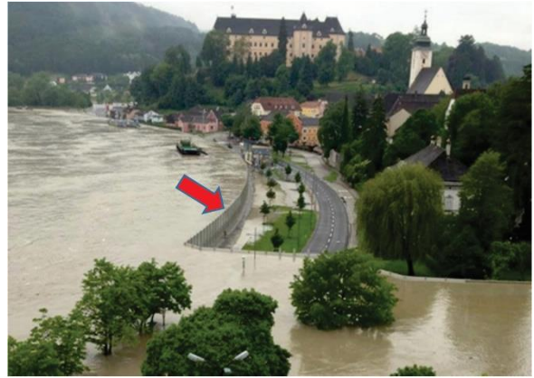
Hình 1: Hình ảnh hệ thống chống tràn di động trong trận lũ tháng 6/2013 tại Grein, Áo
