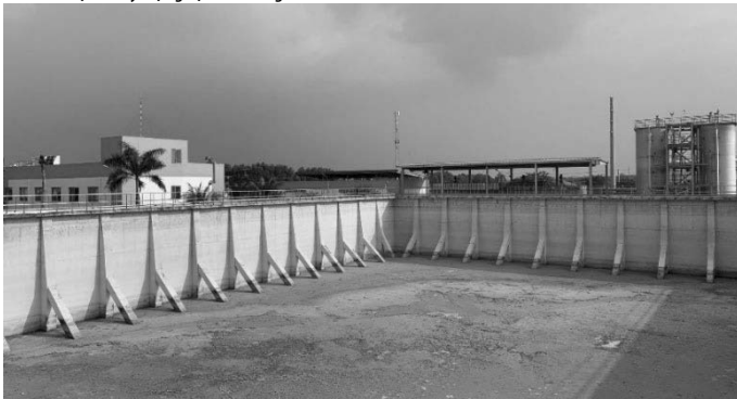
Bể ứng phó sự cố do nước thải Nhà máy Giấy xây dựng bằng BTCT
