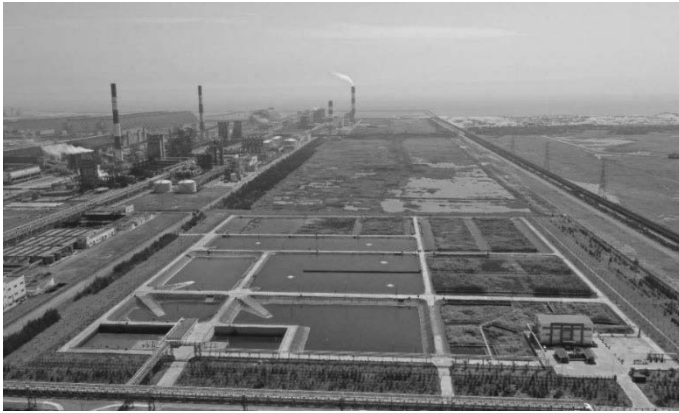
Hồ xử lý nước thải kết hợp chuỗi hồ sinh học và bãi lọc trồng cây
