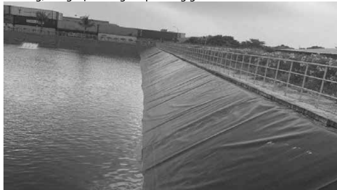
Hồ ứng phó sự cố do nước thải của khu công nghiệp
