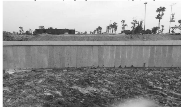
Bể xử lý sử dụng cứ UHPC kết hợp cọc neo
