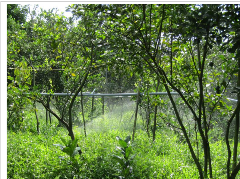
Hệ thống phun nước tự động vườn nhà anh Triển
