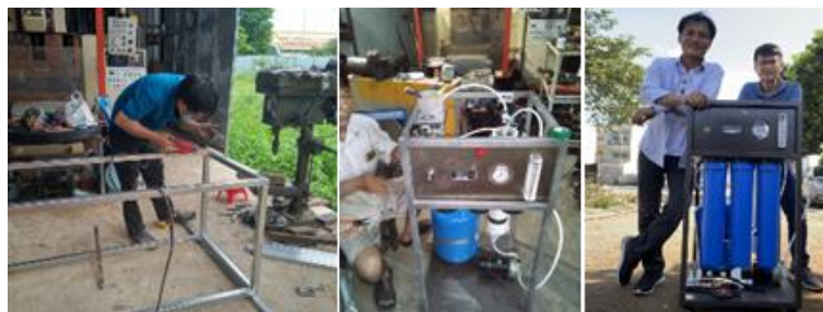
Hình 8. Gia công và lắp đặt thiết bị, (a) gia công khung bao che; (b) lắp đặt; và (c) thiết bị chế tạo.
