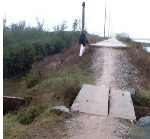
Hình 5. Mực nước biển những ngày triều cường sau năm 2000 dâng cao hơn trước đó khoảng 70cm. Trạm Kiểm lâm phải xây dựng lại nhà mới có nền nhà cao hơn trước (phải) và đê biển cũng phải tôn cao lên (trái) (Ảnh chụp tháng 12 năm 2011).
