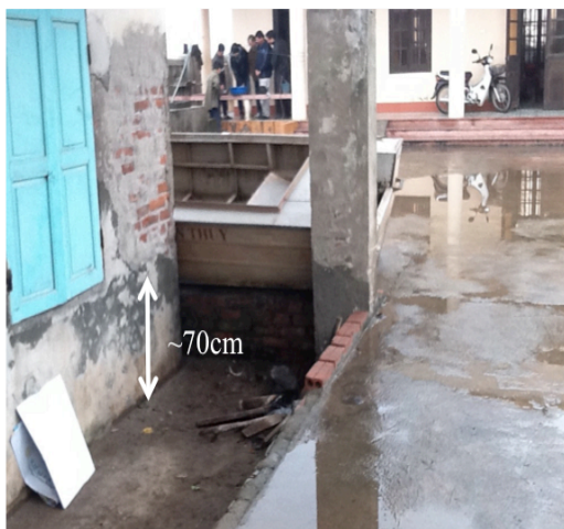
Hình 5. Mực nước biển những ngày triều cường sau năm 2000 dâng cao hơn trước đó khoảng 70cm. Trạm Kiểm lâm phải xây dựng lại nhà mới có nền nhà cao hơn trước (phải) và đê biển cũng phải tôn cao lên (trái) (Ảnh chụp tháng 12 năm 2011).
