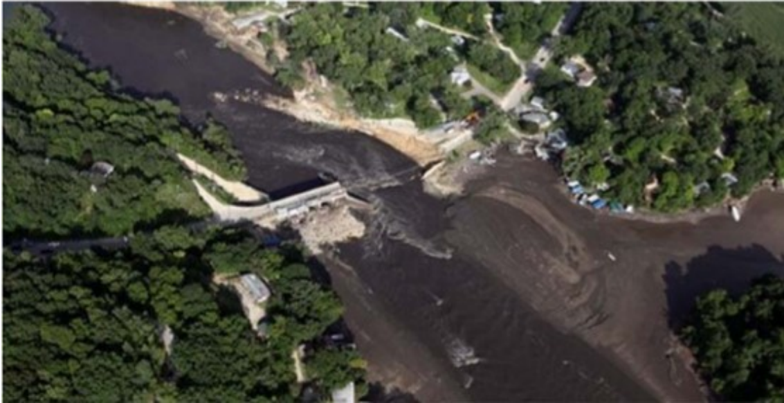
Hình 1. 2. Đập Delhi bị vỡ và dòng nước cuộn cuộn chảy về hạ lưu.
