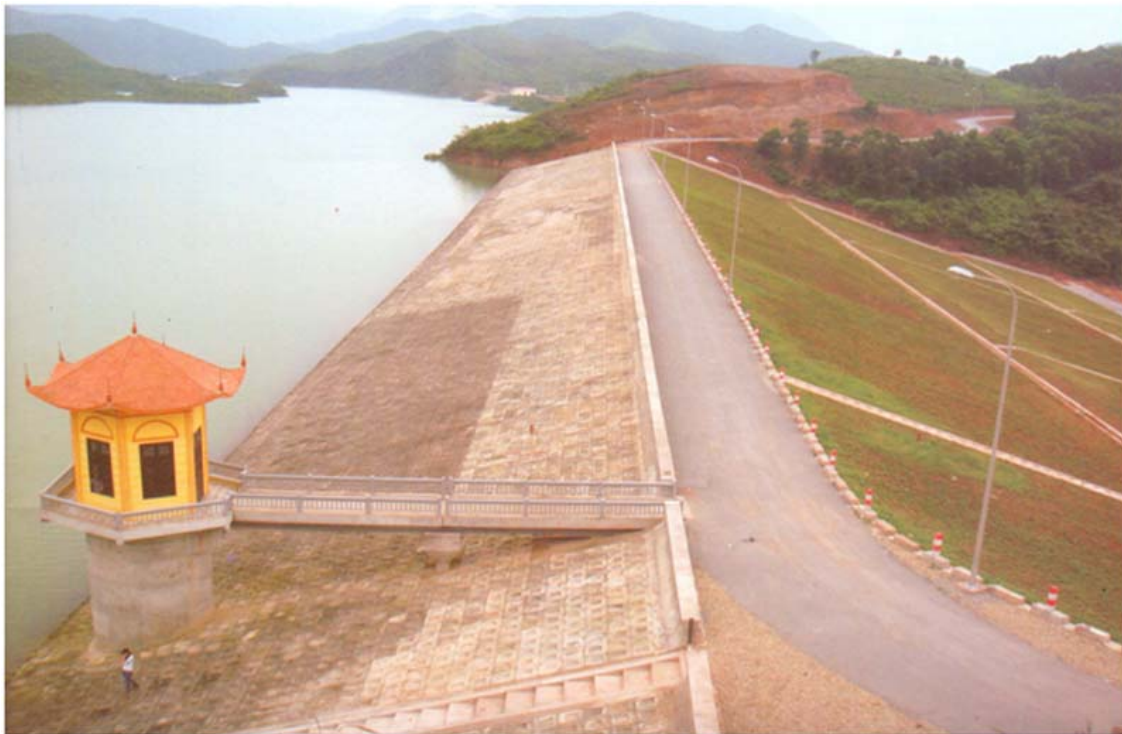
Hình 4. 1. Toàn cảnh hồ đập Đầm Hà Động (thời điểm chưa xảy ra sự cố)
