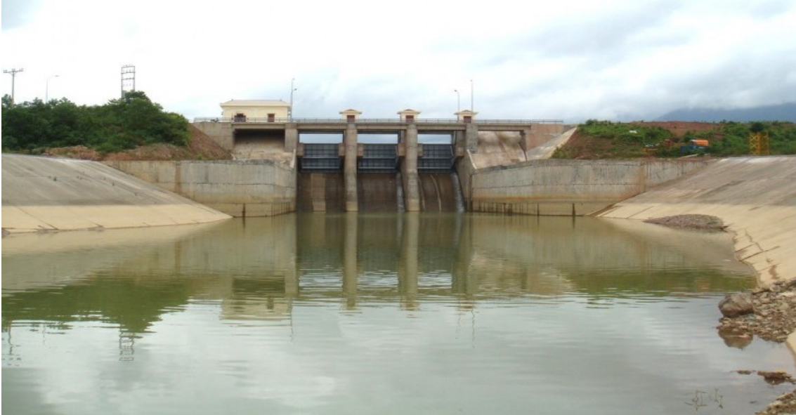
Hình 4. 2. Hạ lưu tràn xả lũ
