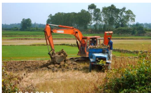
Điểm TN Lương Hòa – Châu Thành – Trà Vinh. Đất bị lấy mất tầng mặt dùng để san lấp nền
